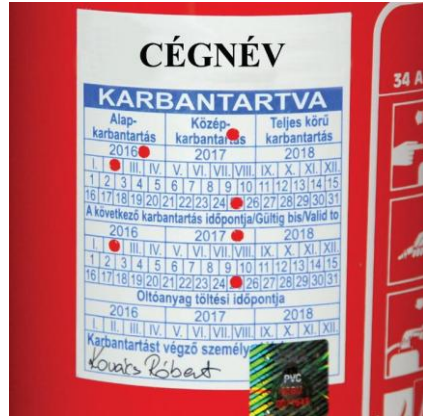
Karbantartást igazoló címke felhelyezése OKF azonosító jellel
