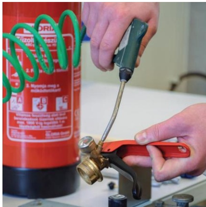
A fejszerelvény kifúvása sűrített levegővel
